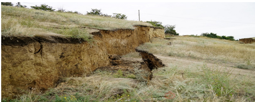
Рисунок 7 Образование уступа вследствие просадки грунта
