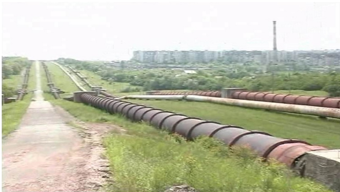
Рисунок 5 Общий вид дюкерного участка канала «Северский Донец – Донбасс» на поле шахты им. Ленина
