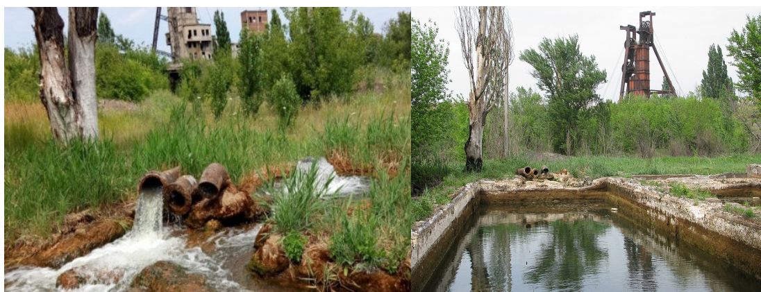
Рисунок 3 Откачка шахтной воды на поверхность или в отстойник
