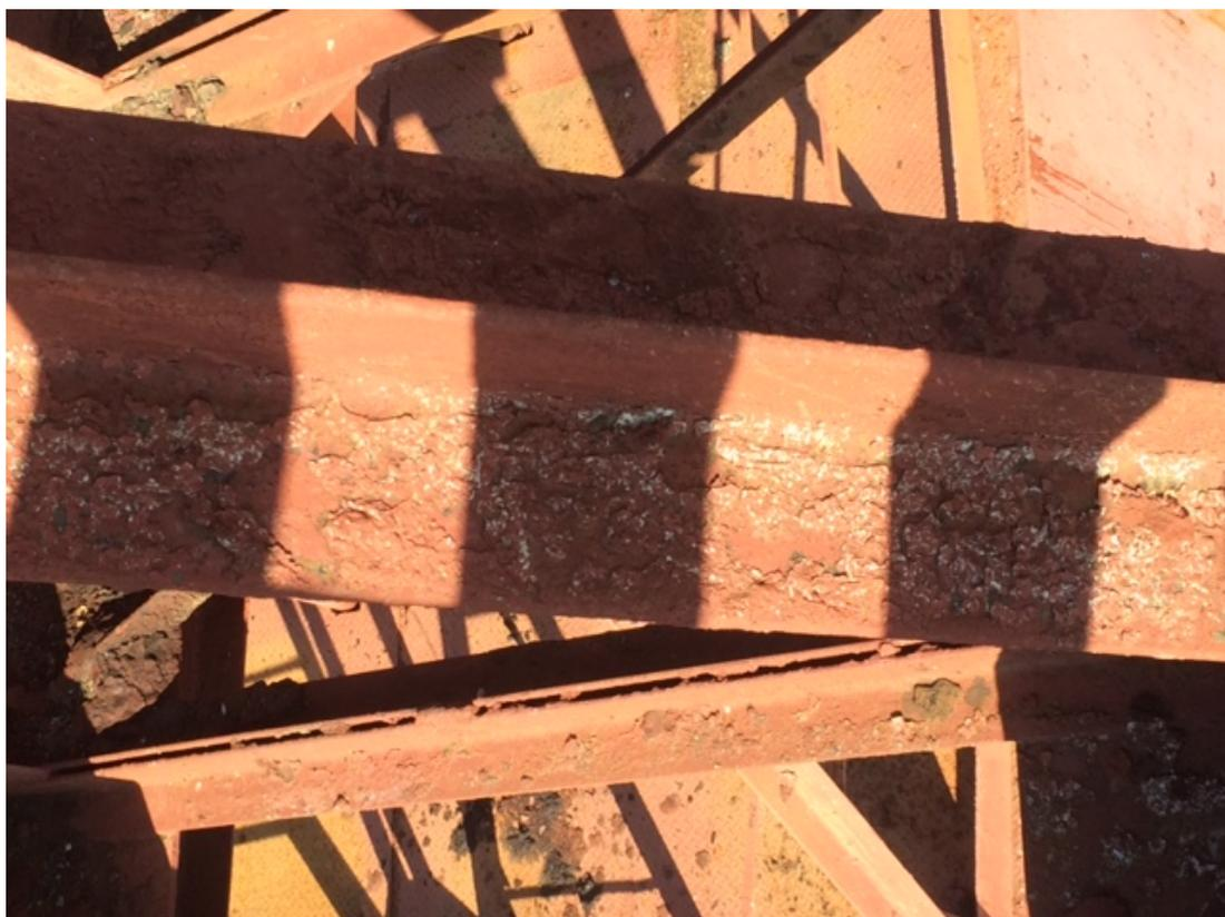
Рисунок 1 Отслаивание лакокрасочного покрытия
