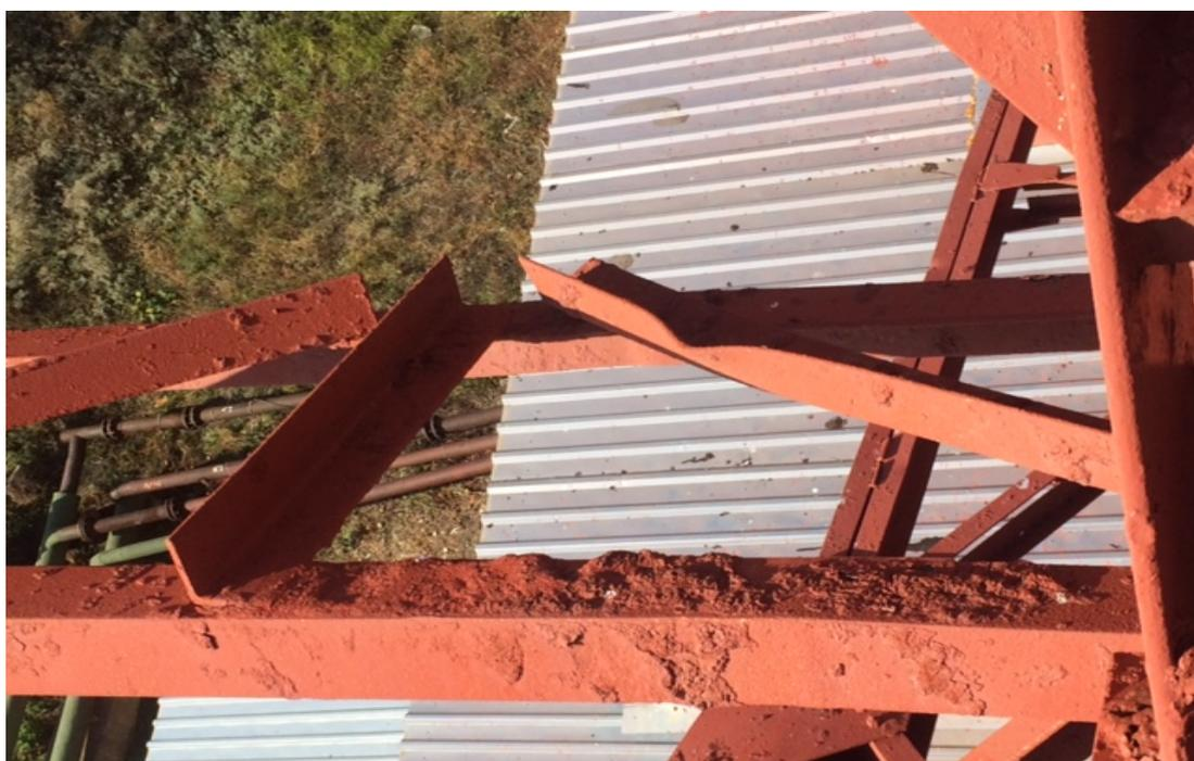
Рисунок 2 Незачищенные участки конструкций копра, по которым проводилось окрашивание
