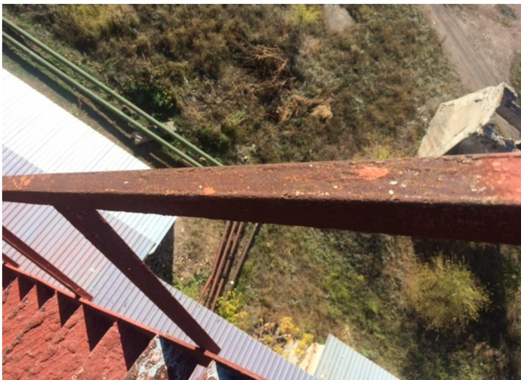
Рисунок 4 Элементы конструкций, на которых уже отсутствует лакокрасочное покрытие
