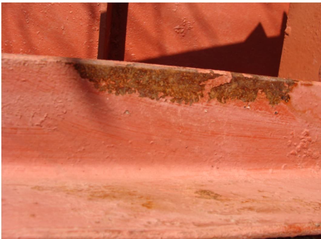
Рисунок 3 Проявление ржавчины на поверхности
