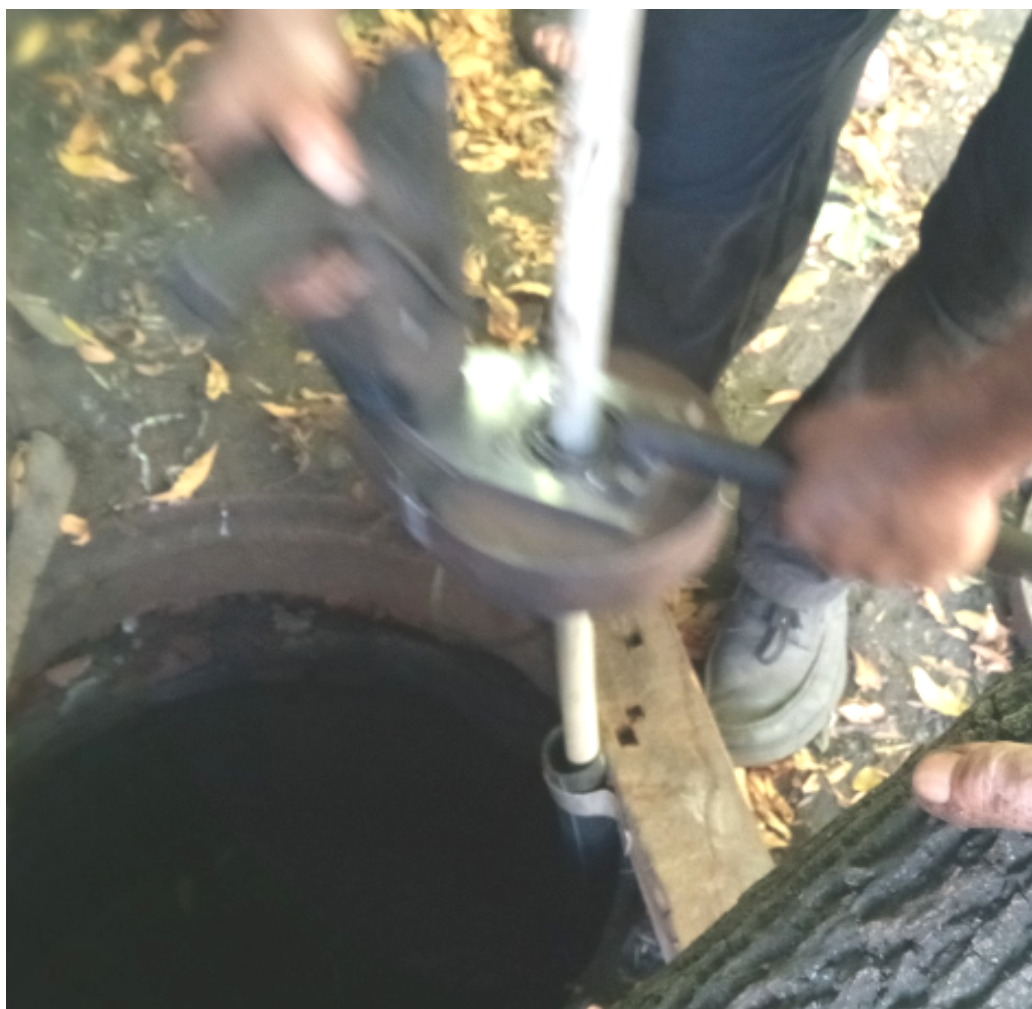
Рисунок 12 Практическая реализация прочистки канализационных труб
