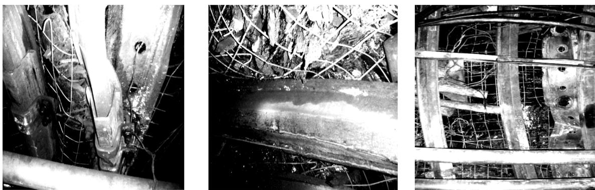
Рисунок 8 – Состояние сетчатой затяжки и межрамных стяжек рамной крепи КМП
