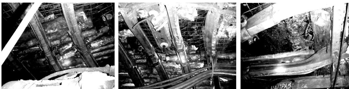
Рисунок 7 – Деформации верхняков рамной крепи КМП: разрывы сплошности, потери продольной устойчивости и скручивания профиля
