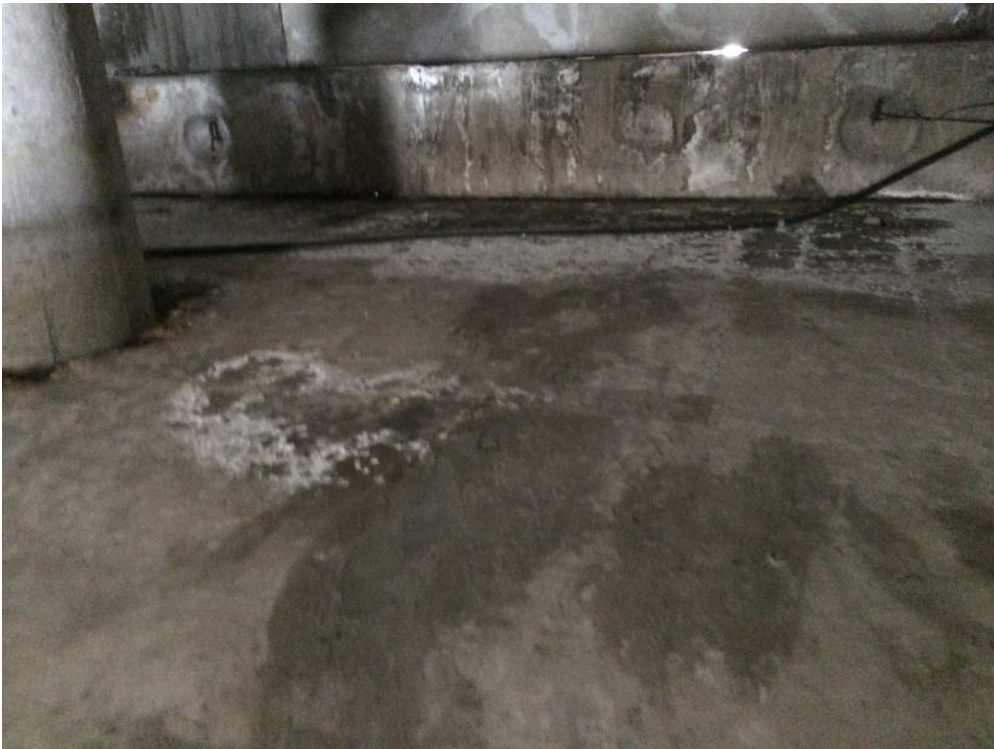
Рисунок 7 — Солевые пятна на техническом этаже
