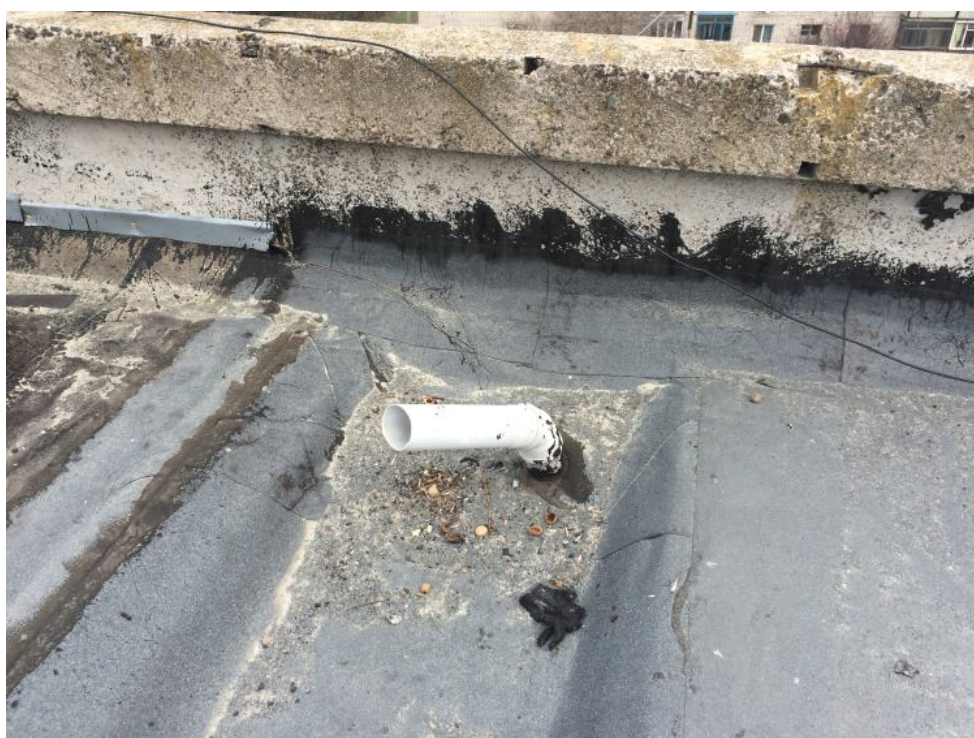
Рисунок 2 — Отсутствие примыканий полотнищ стеклоизола и фиксирующих планок
